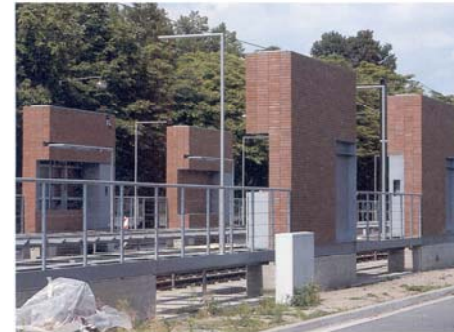
Einer von vier bereits fertiggestellten Haltepunkten: Freundallee mit Ziegelverkleidung
